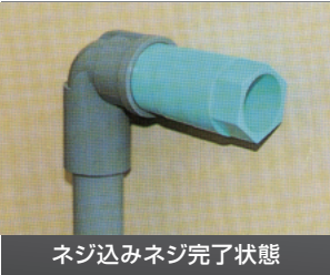
ネジ込みネジ完了状態
